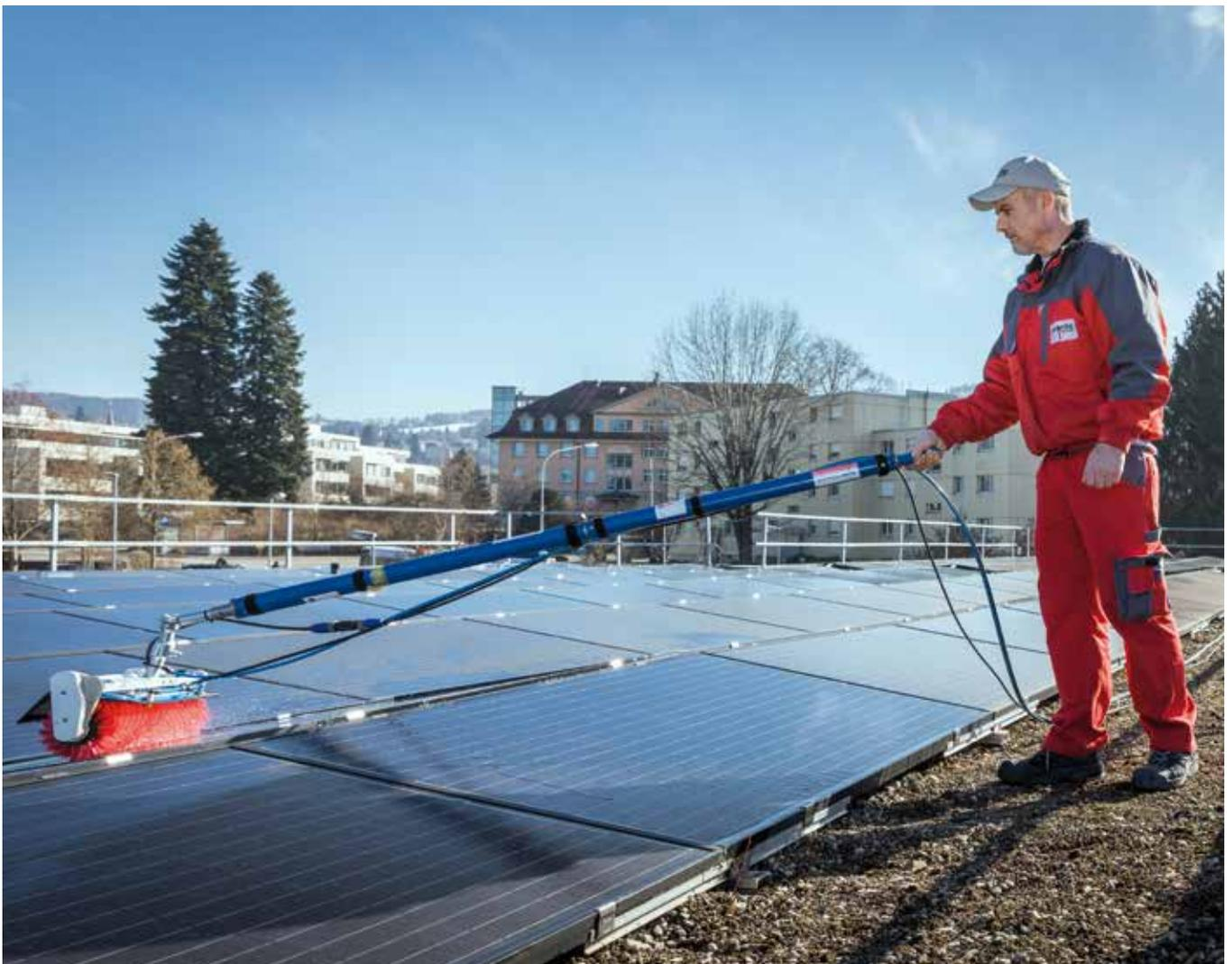
Sonnenpanels behandelt Pronto mit Reinwasser, bevor sie der Schmutzschicht mit Spezialbürsten material-schonend zu Leibe rücken.
