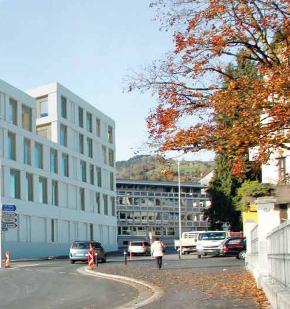
Die beeindruckende Fassade ist vorgehängt und hinterlüftet. Auf optimalen Schallschutz wird grössten Wert gelegt.
