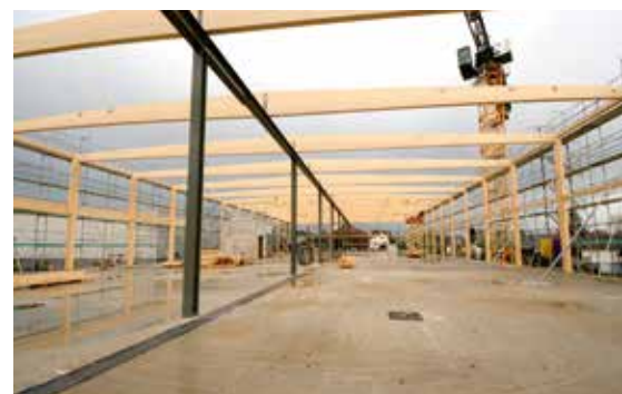
Das Holztragwerk der neuen Lagerhalle der RWD Schlatter.
