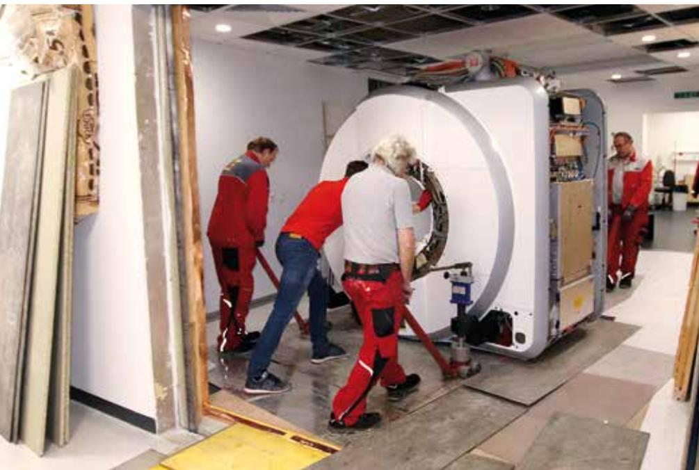
Der Umzug der verschiedenen Geräte der Radiologie erfolgte durch die Firma Siemens in mehreren Etappen. Relativ aufwändig musste das MRI Tesla 1.5 mit einem grossen Mobilkran aus der Fensterfassade des 1. Obergeschoss vom Bettenhauses gehoben werden.
