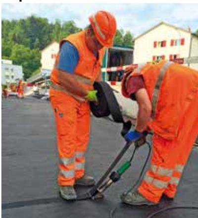
Einbau der Unterschottermatte zur Minimierung der Emissionen.
