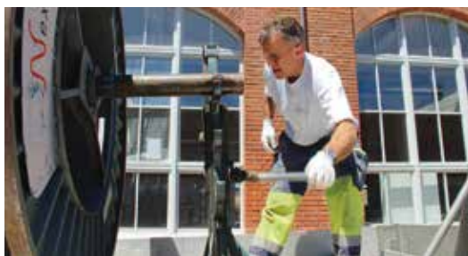
Ein Kabelzug beim Hamel-Gebäude.
