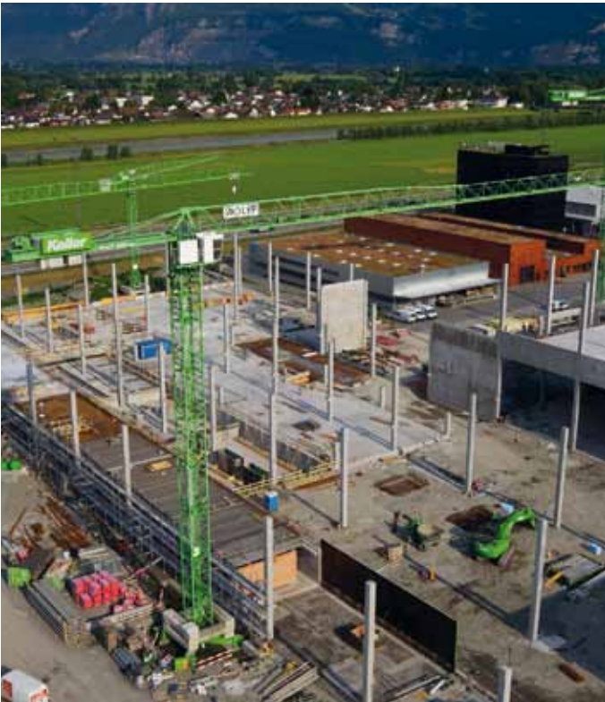
Produktionshallen Rexam in Widnau ATP Innsbruck
