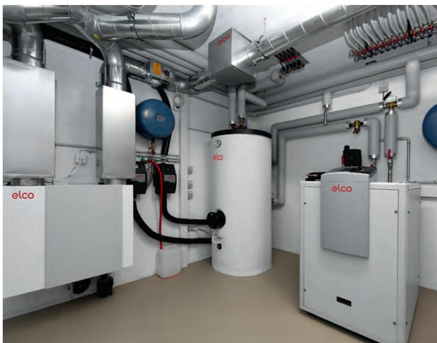
Blick in den Heizungskeller mit (v.l.n.r.) Komfortlüftungsgerät AIRSYSTEM, Solarspeicher und Wärmepumpe AQUATOP T 08C von ELCO.
