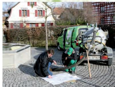
Abb. 3 Aufnahme des Leitungsverlauf zur Erstellung einer Skizze
