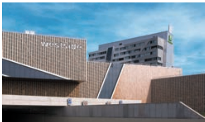
Die EUPRO AG vermittelt auch Personal für Grossbaustellen, wie beispielsweise das Westside-Zentrum in Bern, das Anfang Oktober eröffnet wurde.
