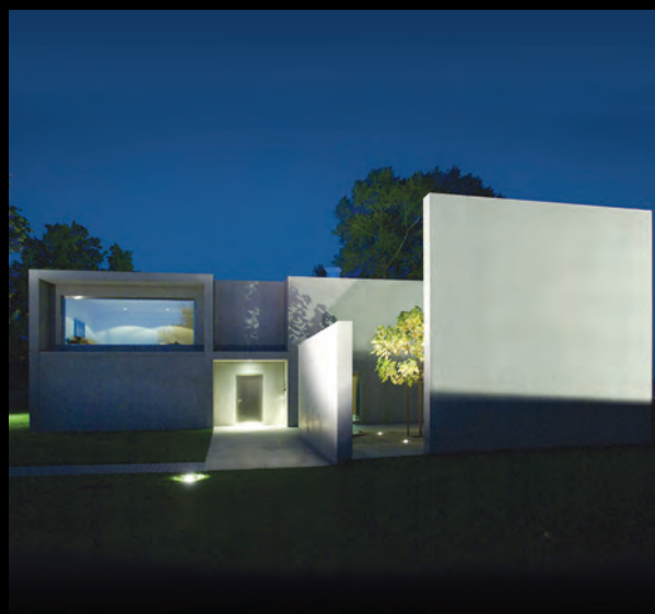
saw spannbetonwerk ag. Marktführer. Betonlemente. Wohnbau und Lofts.
