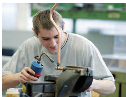
Sanitär-Installateur-Lehrling beim Lötén
