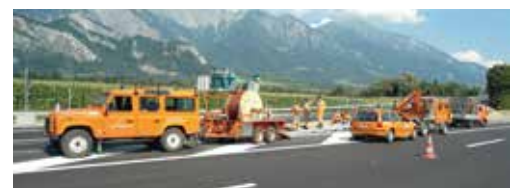
Arbeiten auf der Autobahn: Das Netzbau-Team beim Grossauftrag für das ASTRA.
