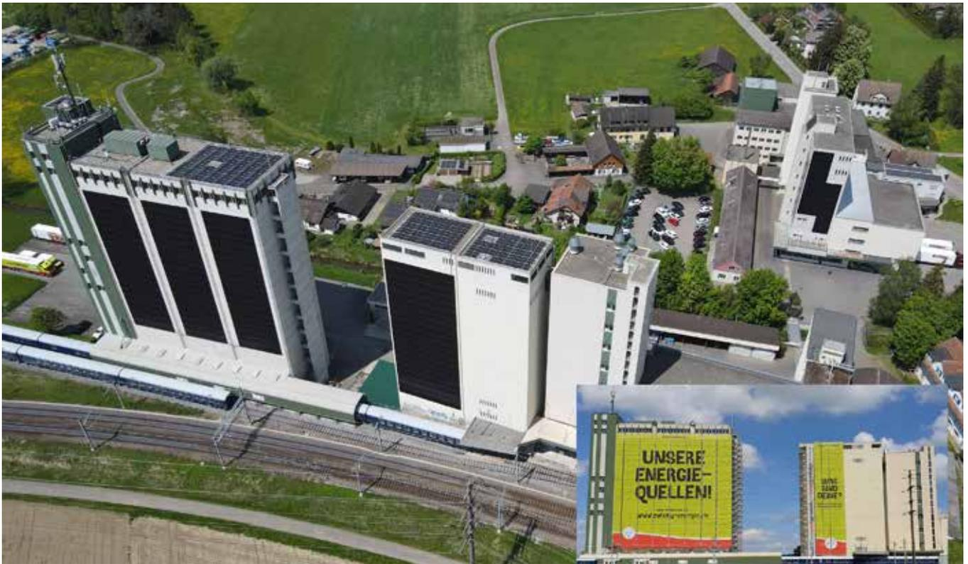
Grosses Bild: Die transparenten Solarmodule sind leistungsstark und generieren  $142,6 \text{ kWh/m}^2$  im Jahr. Dies entspricht über 300% mehr Solarstrom als bei gefärbten Modulen (mit  $34,7 \text{ kWh/m}^2$ ).
