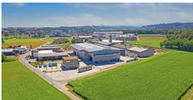
Recyclingcenter am Standort Sulgen mit PV-Anlage.
