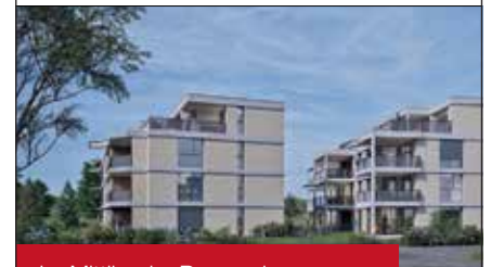
Im Mittlislizelg, Romanshorn
