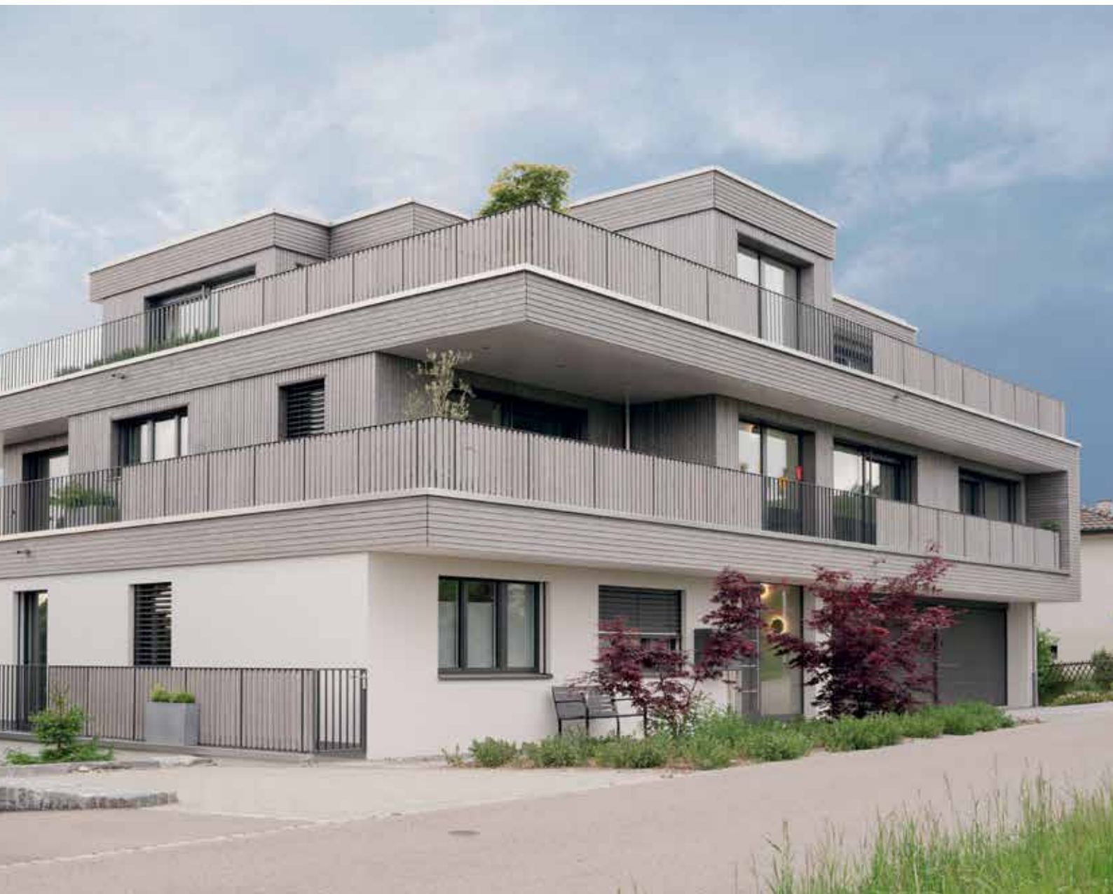
Mehrfamilienhaus in Holzbauweise mit integrierter Planung und hoher Vorfertigung.
