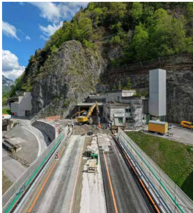
Die Erneuerung des Kerenzerbergtunnels ist in vollem Gang.
