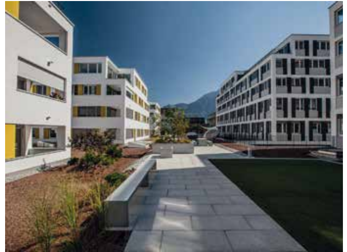
Neubau Wohn- und Geschäftshaus Blickpunkt, Buchs
