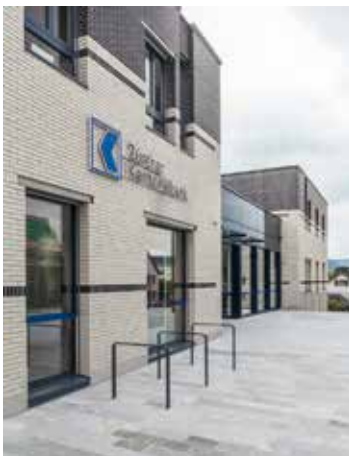
Umbau Zürcher Kantonalbank, Meilen
