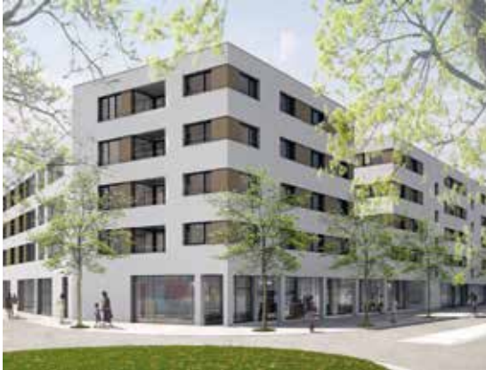
Neubau 36.5° Wohnen mit Freiraum, Stil und Service, Heerbrugg
