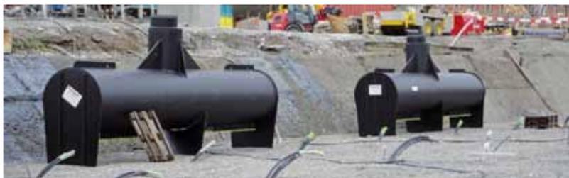
Zwei der insgesamt sechs Verteilerschächte mit Sondenanschluss von unten
