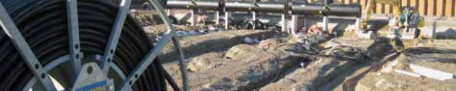
Erstellen der Anbindeleitung und Installation der Verteilerschächte
