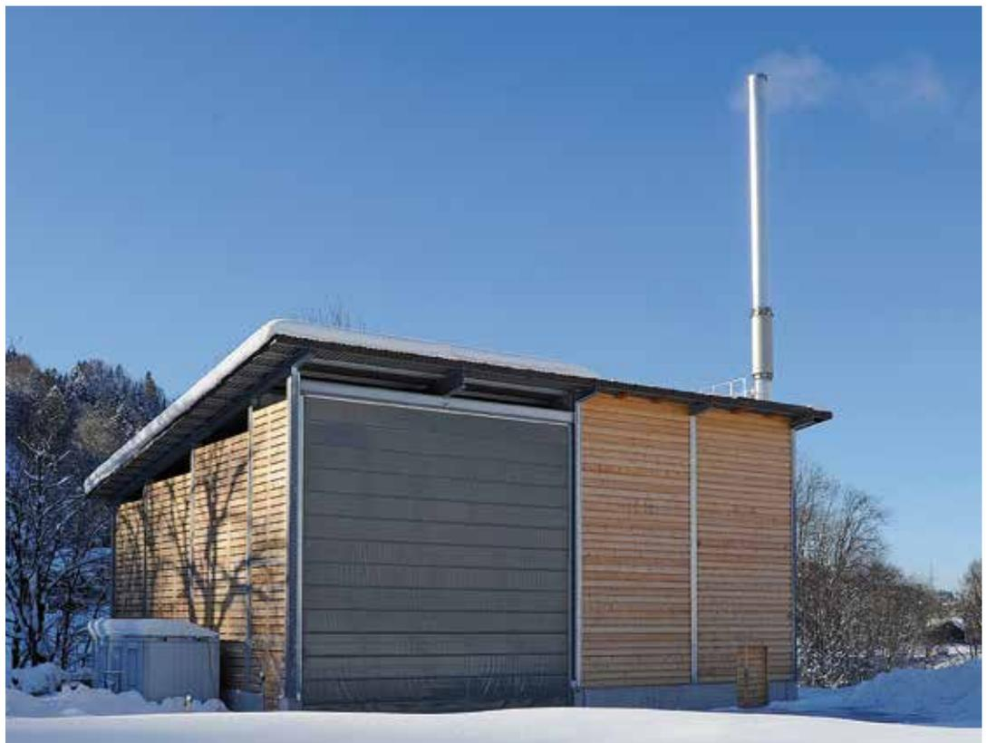
*Die beiden Kessel der Heizanlage mit einer Leistung von 900 kW beziehungsweise 1200 kW versorgen rund 80 Abnehmer in Bühler mit Wärme.*
