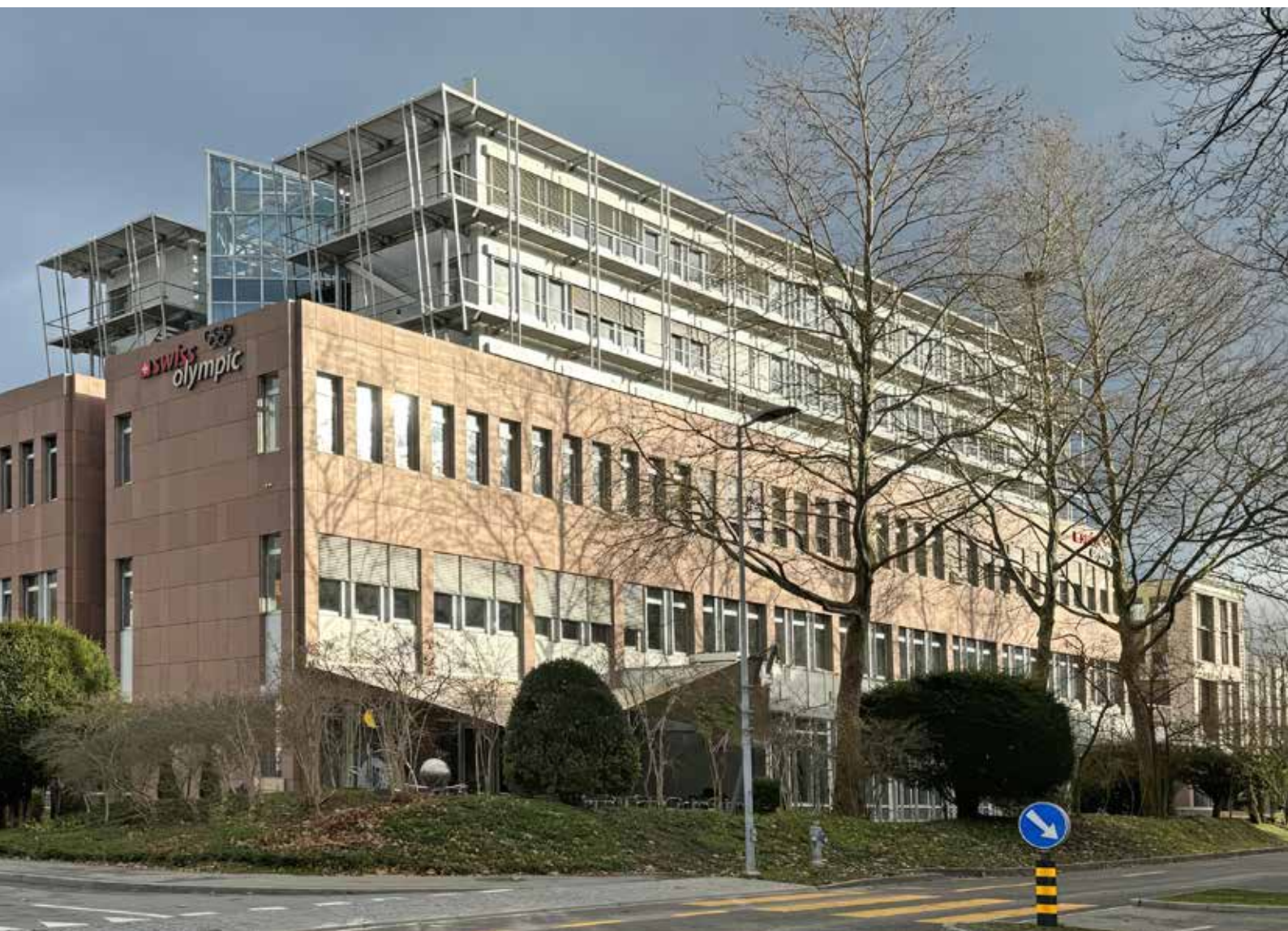
Haus des Sports in Ittigen: Für zehn Millionen Franken hat die Selectivbau AG aus St.Gallen, ein Tochterunternehmen der Thoma Immobilien-Gruppe und der Bereuter Architekturbüro AG, das Gebäude saniert und Ende 2024 wiedereröffnet.
