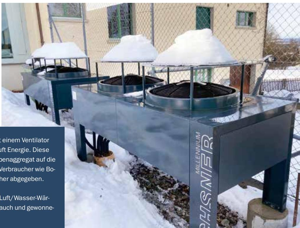
Eine Luft/Wasser-Wärmepumpe fördert Luft mit einem Ventilator durch einen Wärmetauscher und entzieht der Luft Energie. Diese gewonnene Energie wird mit einem Wärmepumpenaggregat auf die gewünschte Heizwärme angehoben und an die Verbraucher wie Bodenheizung, Radiatoren und Warmwasserspeicher abgegeben.
