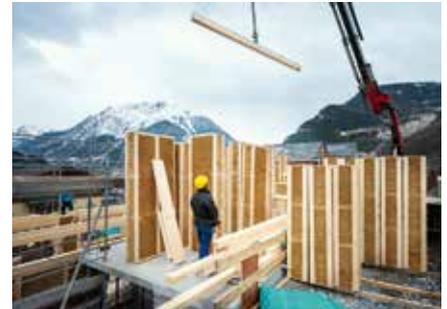
Aus vorgefertigten Elementen aus Stroh und Holz entsteht ein klimafreundlicher Neubau (GEAK A/A) in Vollèges (VS). (Bilder: © Fluxif, Gerry Nitsch, DasGebäudeprogramm)
