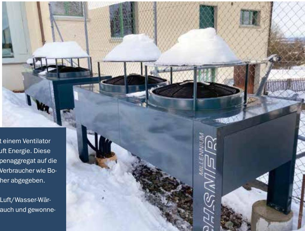
Eine Luft/Wasser-Wärmepumpe fördert Luft mit einem Ventilator durch einen Wärmetauscher und entzieht der Luft Energie. Diese gewonnene Energie wird mit einem Wärmepumpenaggregat auf die gewünschte Heizwärme angehoben und an die Verbraucher wie Bodenheizung, Radiatoren und Warmwasserspeicher abgegeben.
