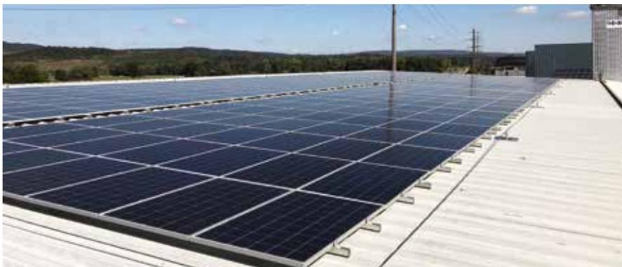
Mit einer Fläche von 620m<sup>2</sup> wurde auf dem Dach der Recyclinghalle die erste Etappe einer Photovoltaikanlage errichtet. Diese wird jährlich rund 100'000 kWh Solarstrom produzieren. Dies entspricht dem jährlichen Strombedarf von rund 28 Einfamilienhäusern. In weiteren Ausbausritten soll die Anlage schrittweise auf den Zielwert von 500'000 kWh ausgebaut werden.
