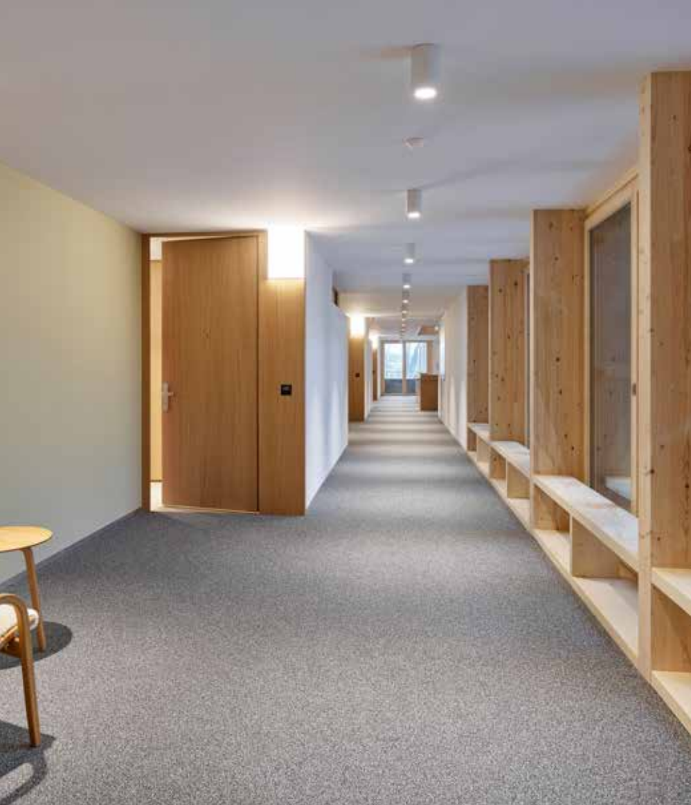
Wohnen im Alter Siegershausen TG: Türen, Fenstersimse und -sitzbänke in Schweizer Massivholz (Eiche und Fichte)
