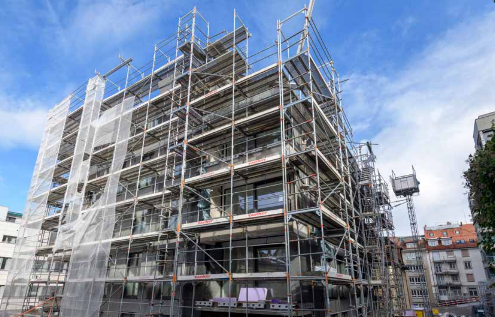
Der Haldenhof in St.Gallen.
