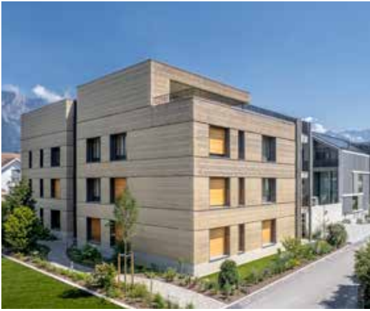
Lehmbau, Haus der Freunde.
