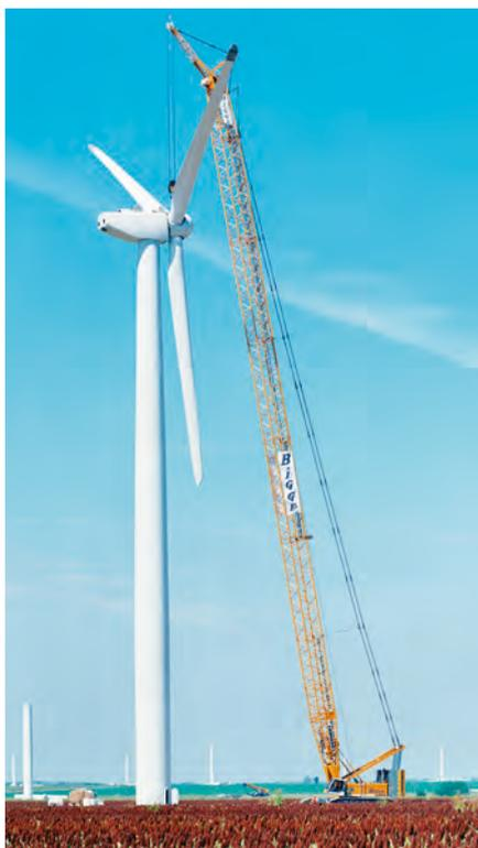
Elektronische Lastmomentbegrenzung unterstützt den Raupenkran bei Montagearbeiten
